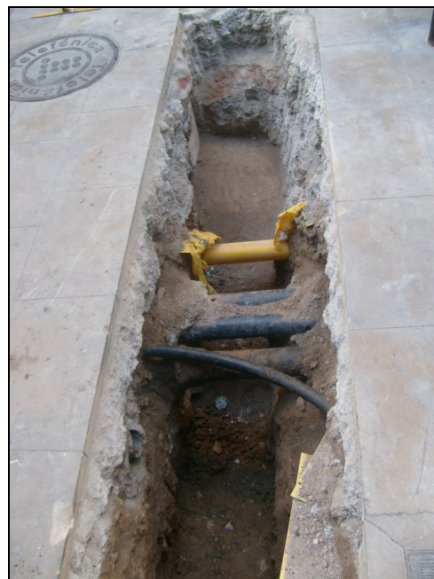
Rasa finalitzada on s'hi aprecien els tubs dels
