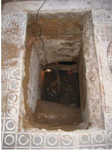
Fotografia 34. Vista d'un dels sondeixos de la rasa U. E. 600.
