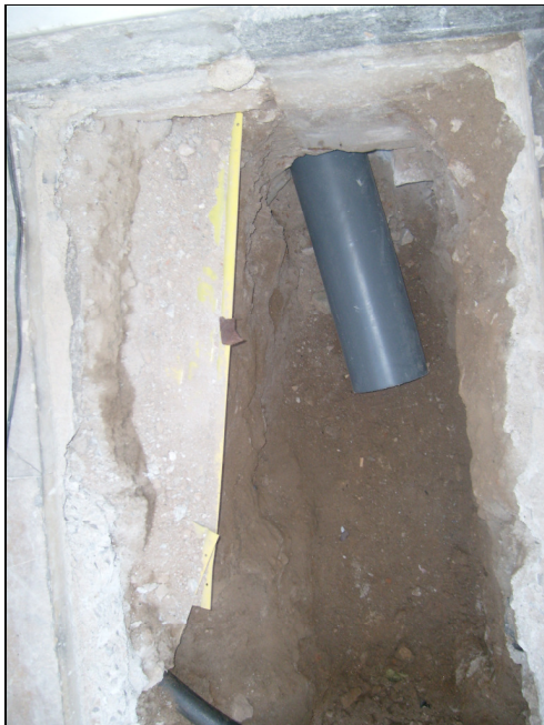
Tub de connexió amb el clavegueram serveis
