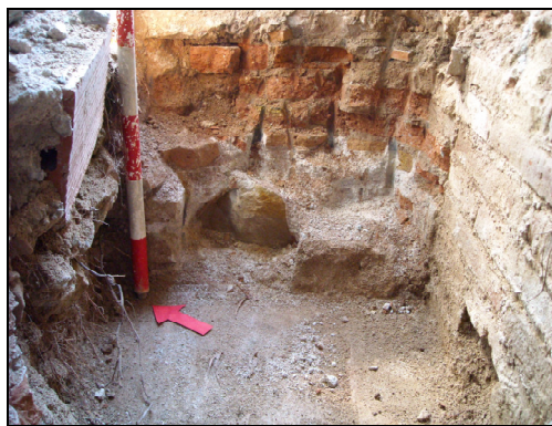
Detall del mur de totxanes (UE: 214) i del posterior mur de pedres (UE: 215) un cop excavats i que probablement funcionin com a fonaments de l'edifici
