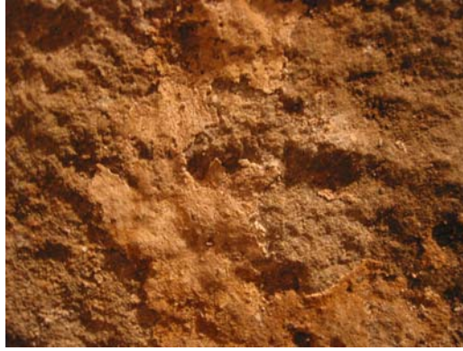
Fotografia 30. Detall de les restes de enlluït U.E. 506.
