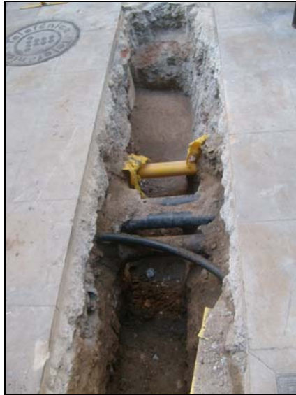
Fotografia 23. Rasa finalitzada on s'hi aprecien els tubs dels serveis.
